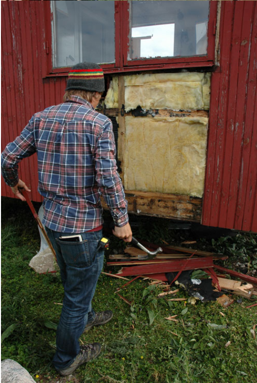
Lite bilder från det omfattande renoveringsarbetet med boden.
